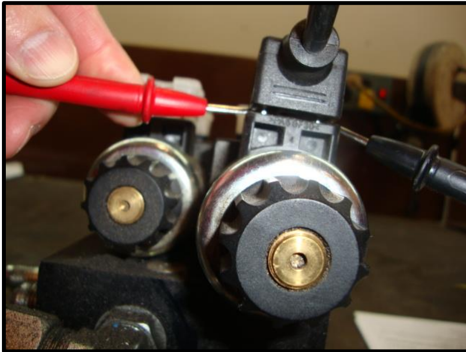
Figure 8-4 Checking Din Plug Voltage
